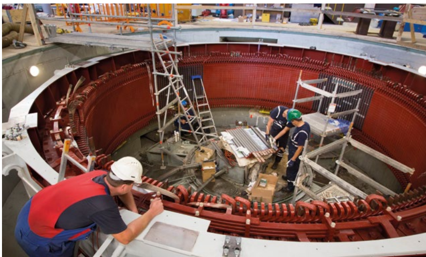
lijoen laitosten jälkeen vuorossa on Melon vesivoimalaitoksen kunnostus Kokemäenjoella. (Kuva: Kai Tirkkonen)
