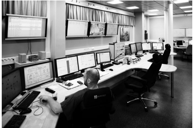
Biovoimalaitosmenun suhteellisen pientä päätä edustaa lämmön ja sähkön yhteistuotantolaitos Keravalla. (Kuva: Kai Tirkkonen)
