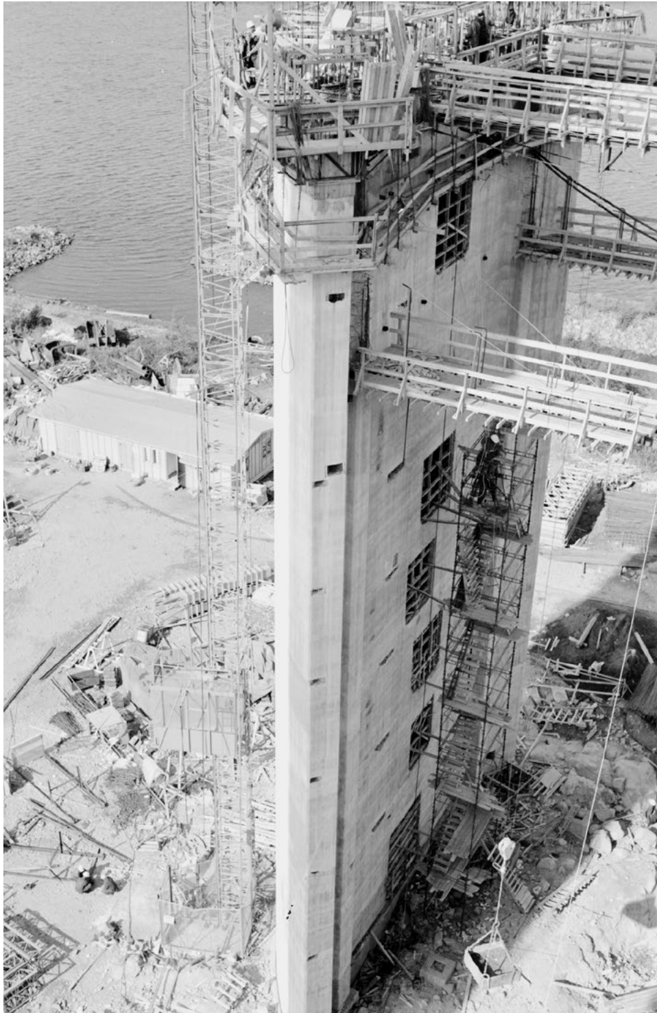
Vaasan Vaskiluotoon nousee höyryvoimalaitos Vaskiluodon Voima. Pohjolan Voima omistaa siitä puolet.
