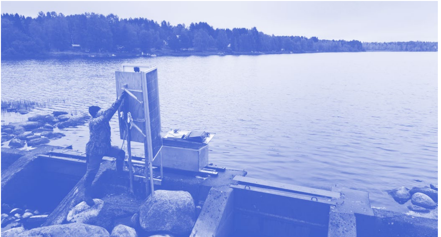
Kalalaskuria asennetaan Raasakan vanhaan uomaan. (Kuva: Kai Tirkkonen)
