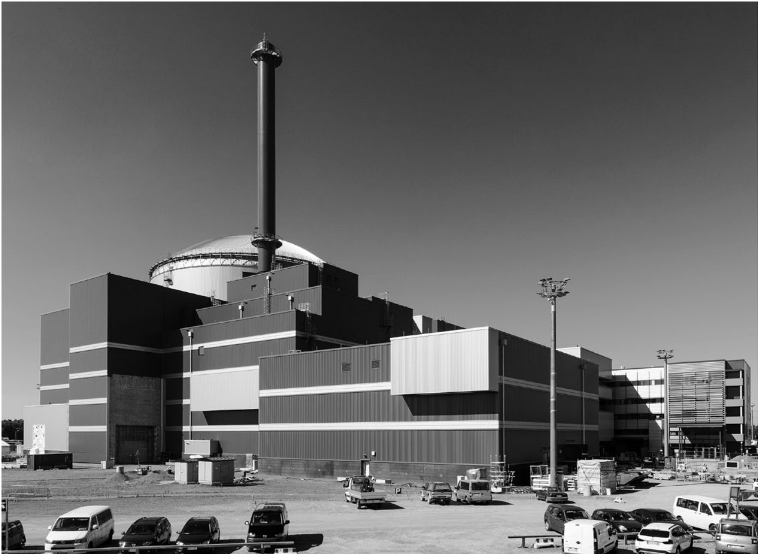
Aluetyöt OL3:sta varten aloitetaan 2004 alussa. Vuoden 2008 lopussa Olkiluodossa työskentelee noin 2500 ihmistä, noin 20 maasta. Vuoden 2017 lopulla työmaalla toimii noin 2000 ihmistä. (Kuva: TVO)
