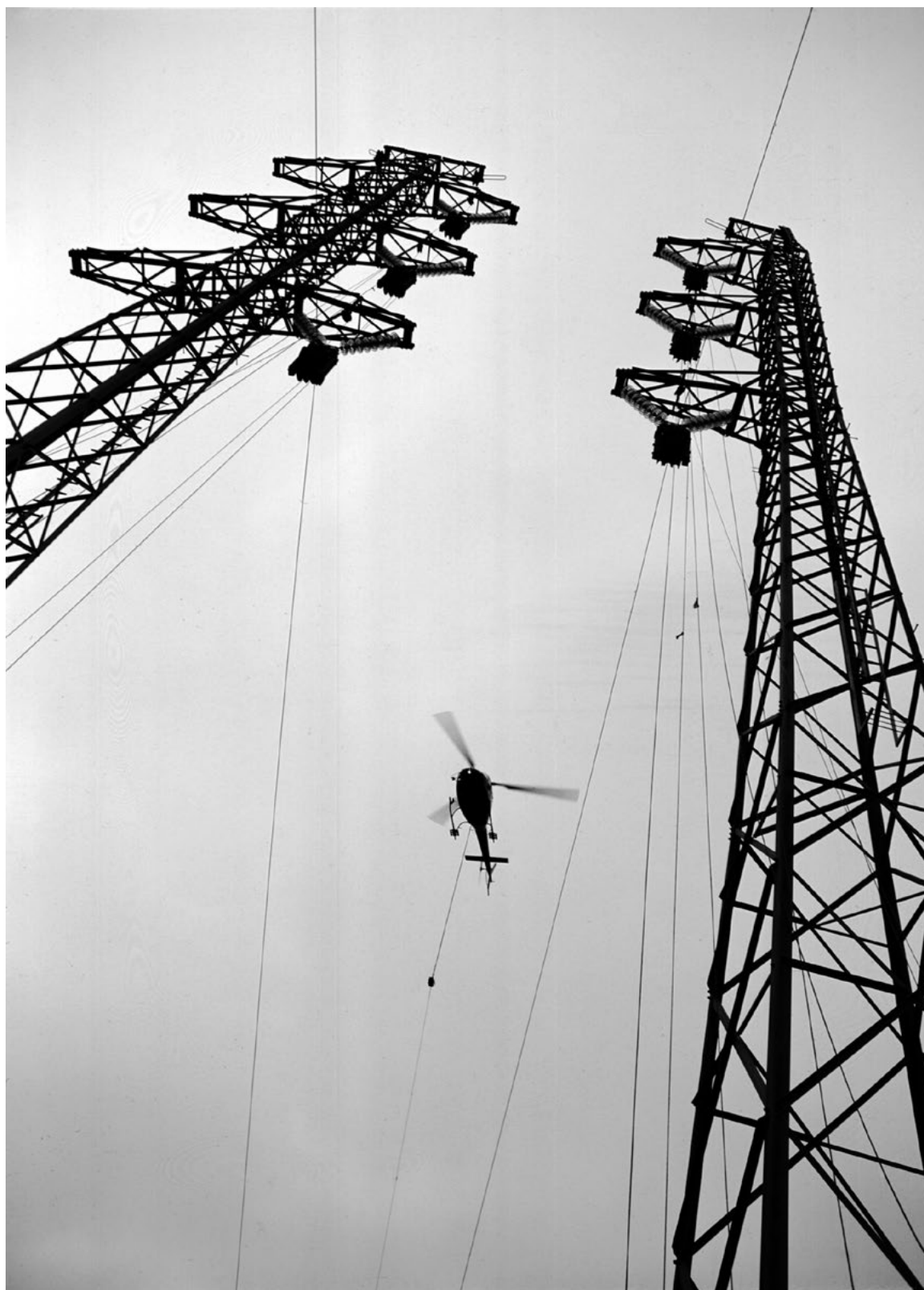
Voimalinjojen rakentaminen on vaativaa erikoistyötä. TVS taitaa sen.
