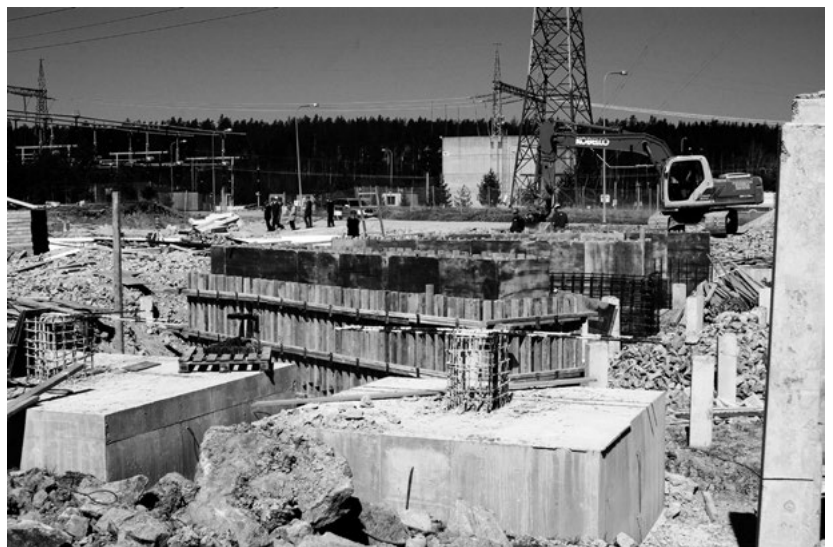
Estlinkin Espoon muuntoaseman perustustyöt meneillään.
