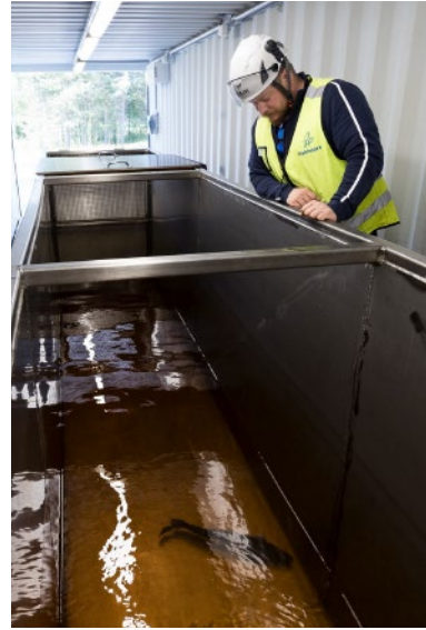
Projektipäällikkö Heikki Meriläinen Kalasydän Oy:sta tarkistaa Raasakassa, miten kalat kulkeutuvat voimalaitoksen yläpuolella olevaan kalakonttiin.
