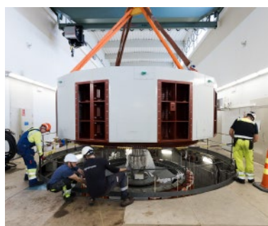
Staattoria lasketaan hallitusti paikoilleen.
