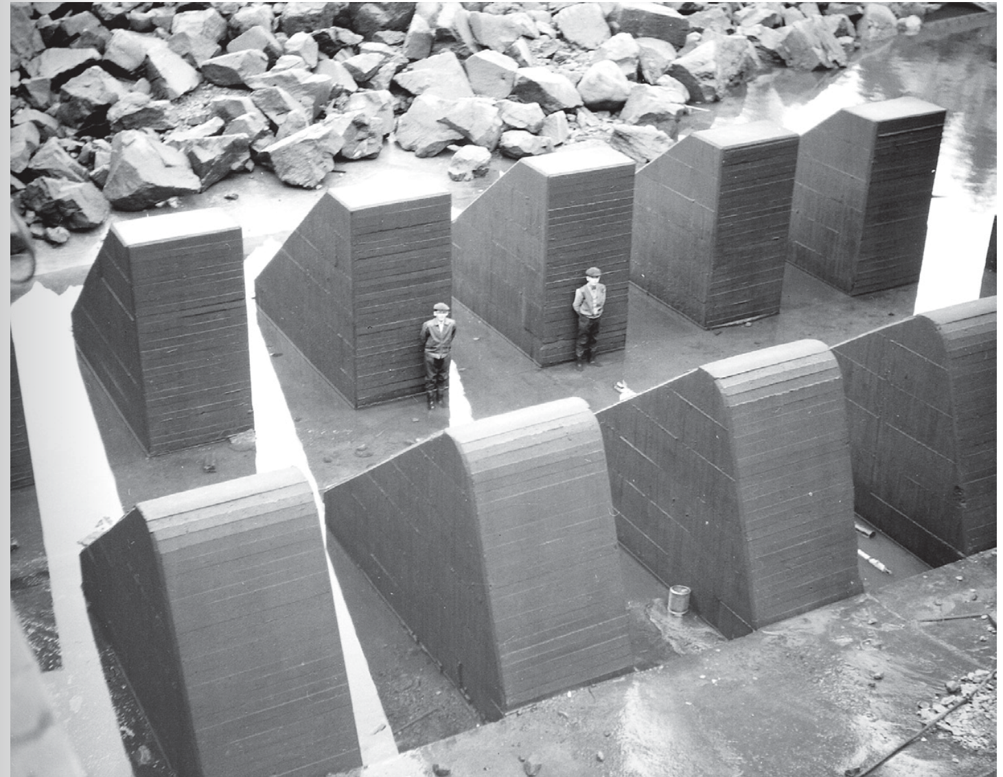
IIJOEN Pahkakosken rakenteilla olevan voimalaitoksen tulva-aukon hampaat vuonna 1961.
