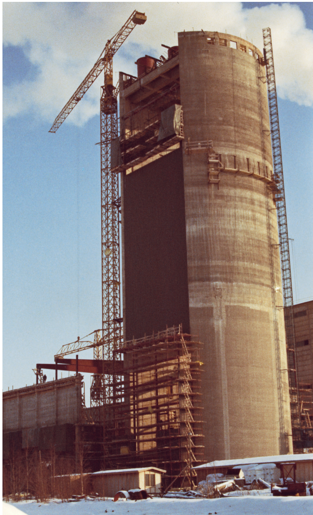
VASKILUODON VOIMAN öljykäyttöisen osakuus- voimalaitoksen rakentaminen aloitettiin vuonna 1969.
