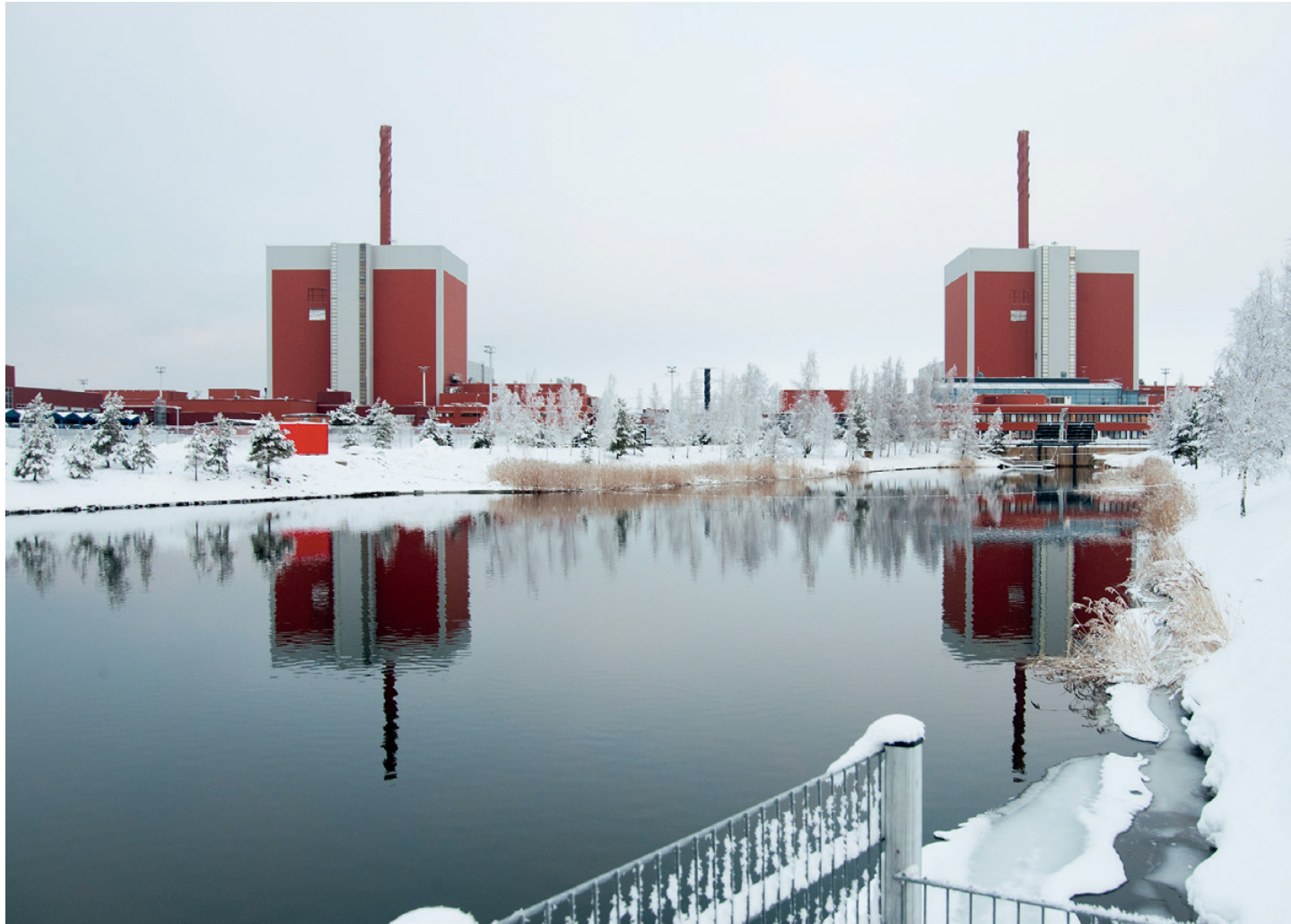
OLKILUODON ydinvoimalaitoksen ensimmäinen laitosyksikkö käynnistyi vuonna 1978 ja toinen 1980.
