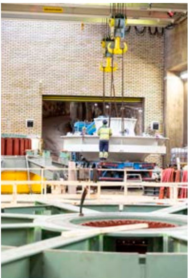
Turbiinin kansi lasketaan paikoilleen.
